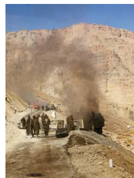
To není peklo, ale opravování silnice do Lehu!
